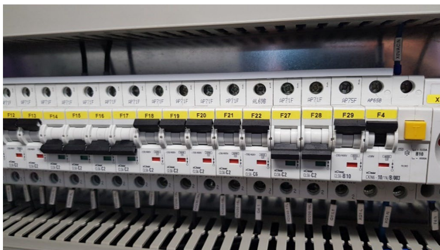
Przykład nr. 4 prawidłowego połączenia zabezpieczeń nadprądowych.
